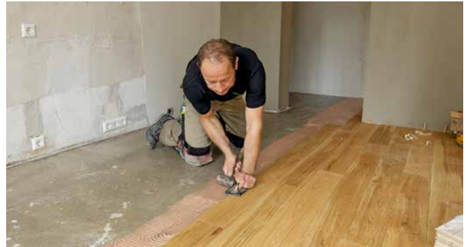
Ein Profi klebt die Eichendielen vollflächig auf den Untergrund. Das sichert eine gute Wärmeübertragung durch die Fußbodenheizung und sorgt für einen niedrigen Trittschall. (Foto: Initiative Parkett im Klebeverbund - PIK)
